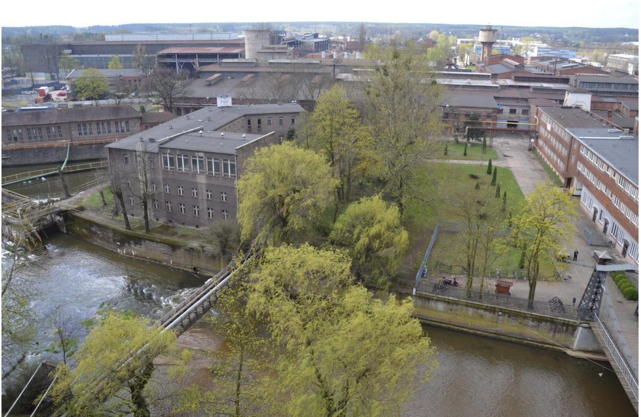
Lokalizacja przejętego budynku w bezpośrednim sąsiedztwie zabytkowego mostu wiszącego z 1827 roku
