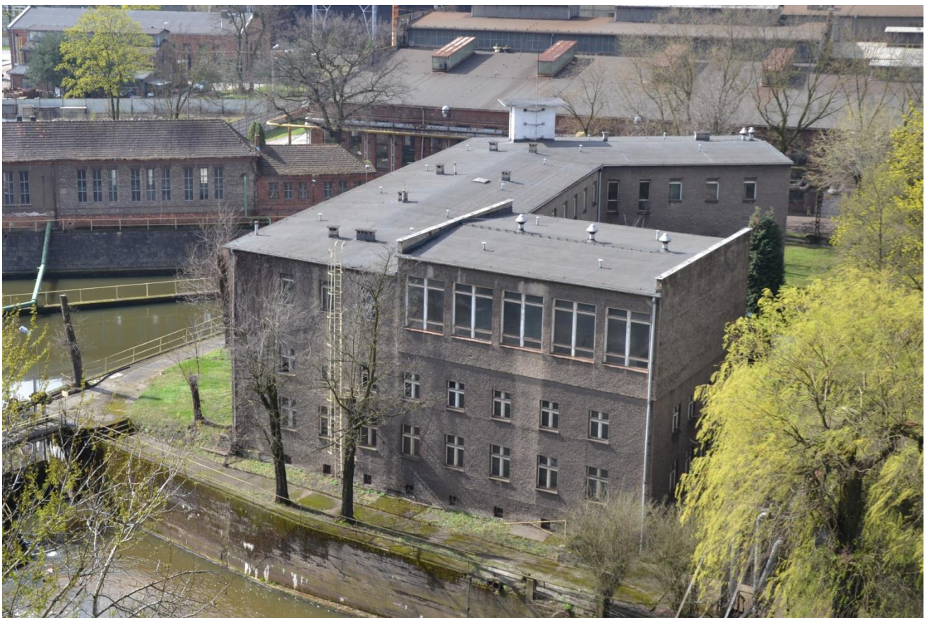
Przejęty budynek z przeznaczeniem na siedzibę Muzeum Hutnictwa Doliny Małej Panwi i Centrum Demokracji Lokalnej
